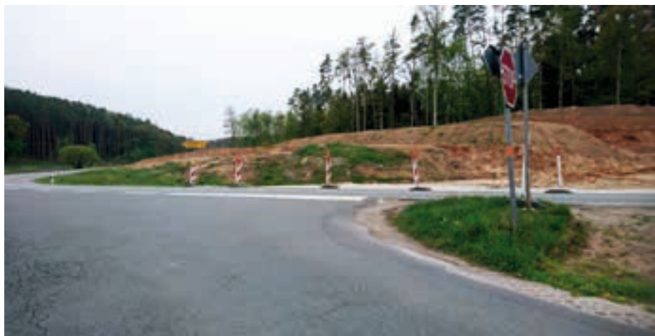
Straße Ammerndorf/Cadolzburg bei Beginn der Begradigungsarbeiten bei Steinbach. Ein massiver Eingriff in die Landschaft, angeblich für mehr Verkehrssicherheit. Das Ergebnis ist eine Asphaltorgie zugunsten von Rasern.
