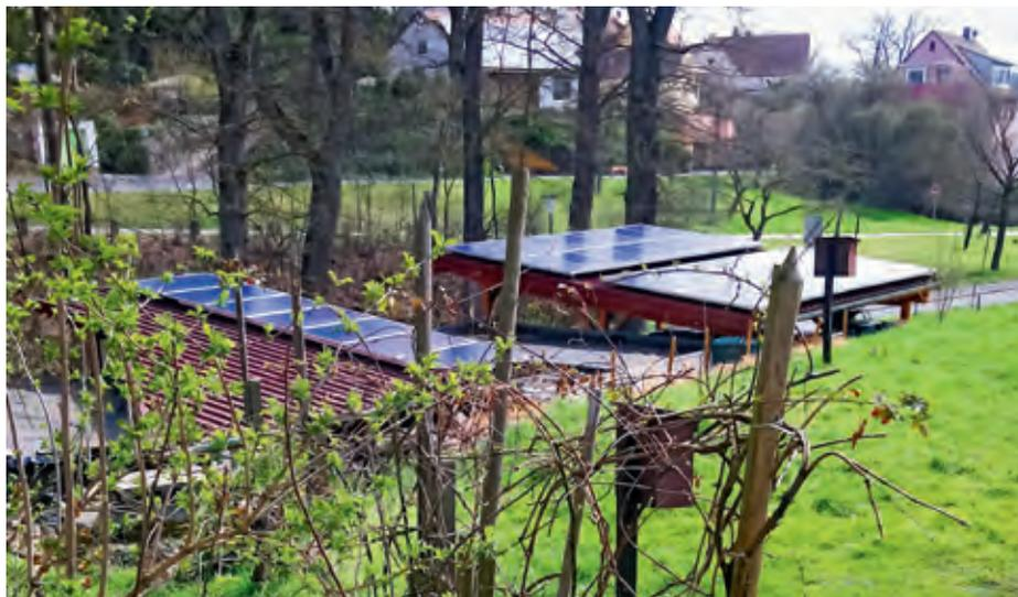
Auf einen Carport montierte Photovoltaikanlage kann Elektrofahrzeuge – evtl. über einen Zwischenspeicher - aufladen. Foto: M. Herrmann
