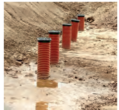
Eine Schwammstadt erfordert erhebliche Baumaßnahmen im Untergrund.
